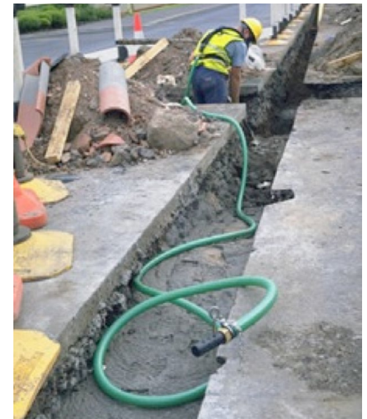
Slika 13. Cijevni uređaj sa svježim zrakom
