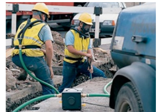
Slika 14. Cijevni uređaj s dovodom čistog zraka pomoću puhalo ili mijeha
